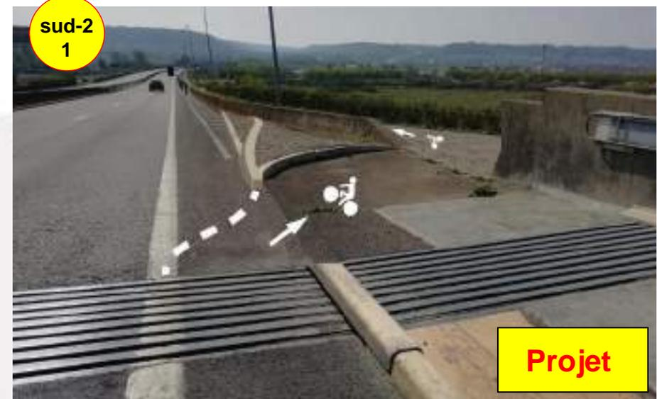
**Solution proposée :** réinsérer les cyclistes derrière la bordure DBA, avec les piétons
