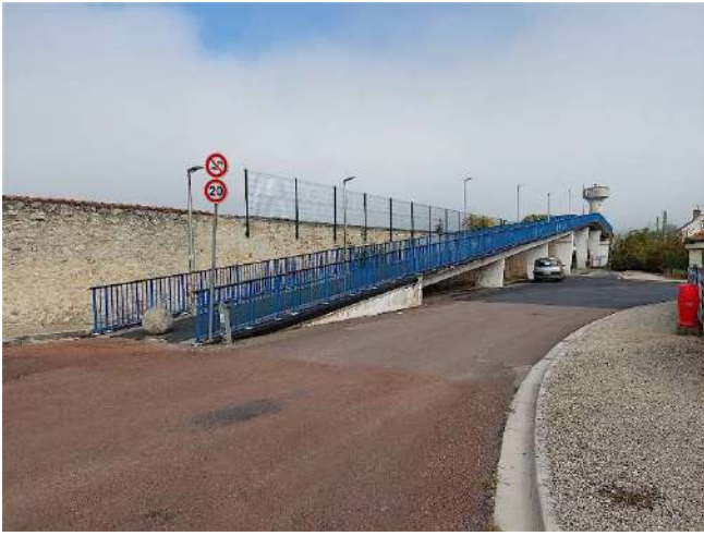
28. Romilly : passerelle de franchissement des voies SNCF
