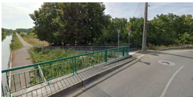
16. Clesles : rampe d'accès à la V33 direction Troyes
