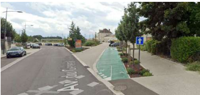
30. Romilly : abords de la gare SNCF
