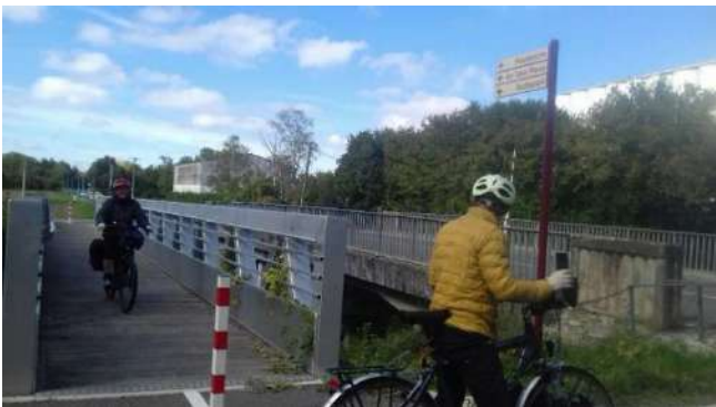
9. Passerelle piéton-vélo à Conflans
