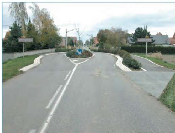
Voie d'évitement manquante ou incomplète en sortie d'agglomération, côté gauche sur la photo
