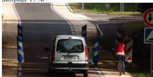
Beau nouveau « Chaucidou » réalisé à Saintes, sur la Route des Gonds (où passe la V92 « Flow Vélo ») : ce sont hélas, là aussi, deux bandes cyclables du fait du marquage T3 5u (ou T3 3u ?).
