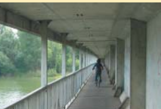
Passage assurant, en caisson accolé à un pont autoroutier existant, la continuité du cheminement vert du lac de Bordeaux, le pont lui-même étant une rocade de 2 x 2 voies à trafic dense
