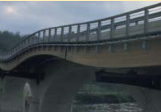
Doublement en bois pour piétons et cyclistes en encorbellement latéral du pont des Eyzies sur la Vézère
