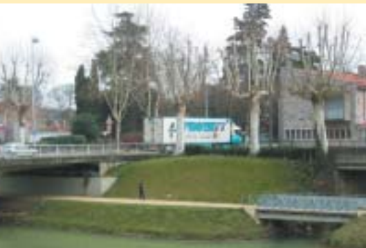
Cheminement le long du Gers protégé très ponctuellement par un garde-corps là où c'est vraiment dangereux (passage étroit sur ouvrage particulier)
