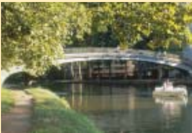
Cheminement passant sous une passerelle existante avec tirant d'air adapté à la navigation (canal du Midi à Toulouse)
