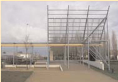
Passerelle moderne dans un paysage de zone industrielle (cheminement le long du Gers)
